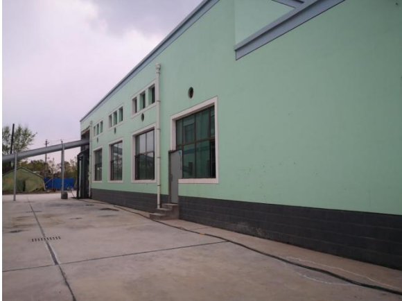
改造污泥压滤间
