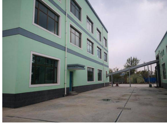
新建污泥处置间
