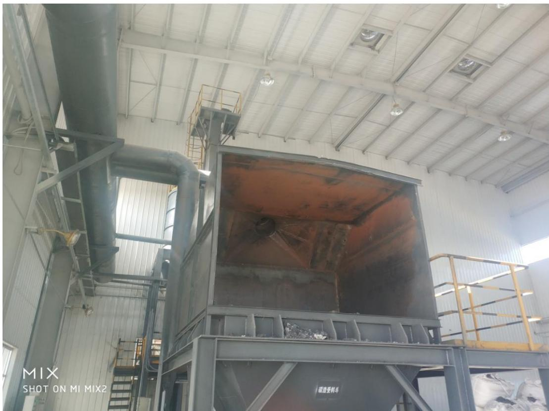
图 4.1-3 碳渣破碎工序除尘设施
