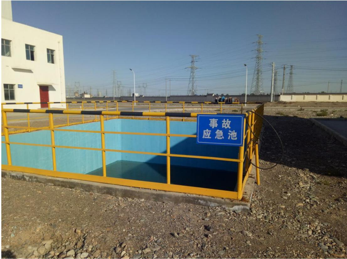
图 4.2-1 铝电解碳渣综合利用生产线事故池
