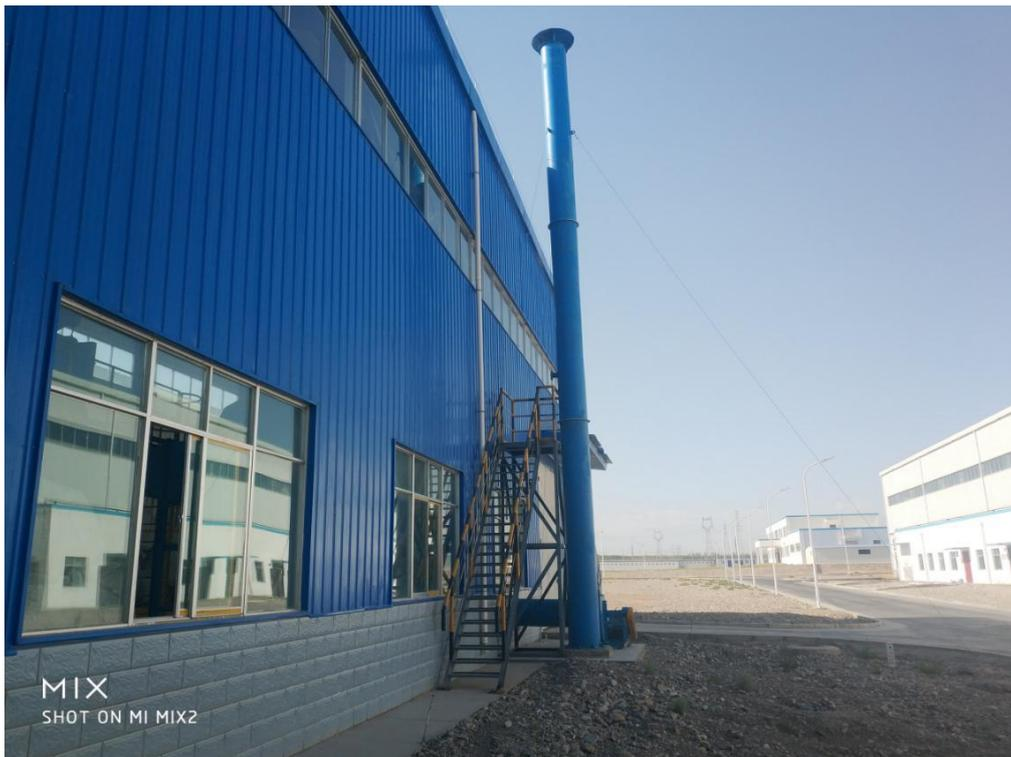
图 4.2-4 废钢棒处理车间有组织废气排放口及监测平台
