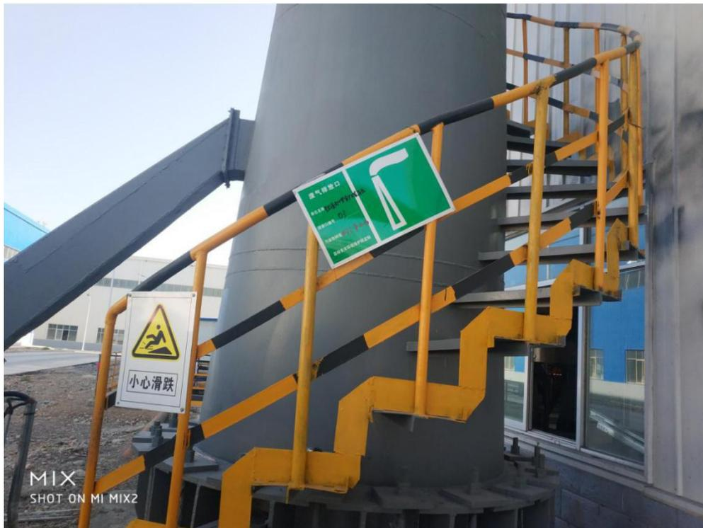
图 4.2-2 铝渣处理生产线有组织废气口标志及监测平台
