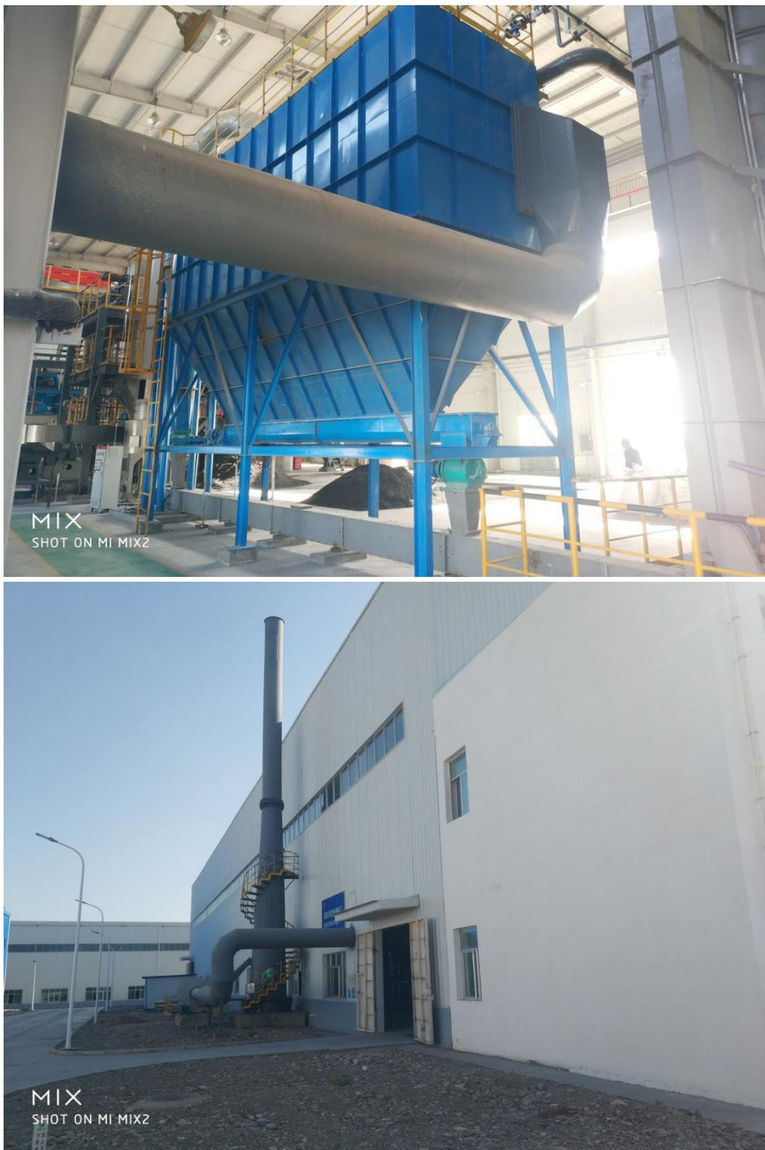
图 4.1-5 冰晶石烘干工序处理装置及排放口
