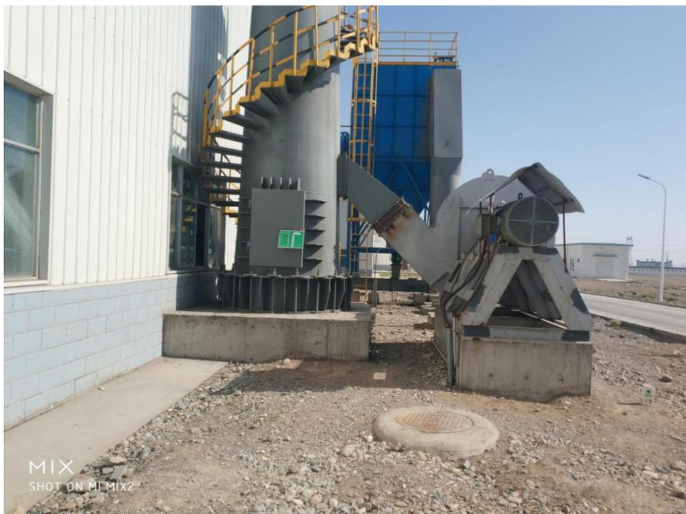
图 4.2-3 铝渣生产线破碎工序排气口标准及监测平台
