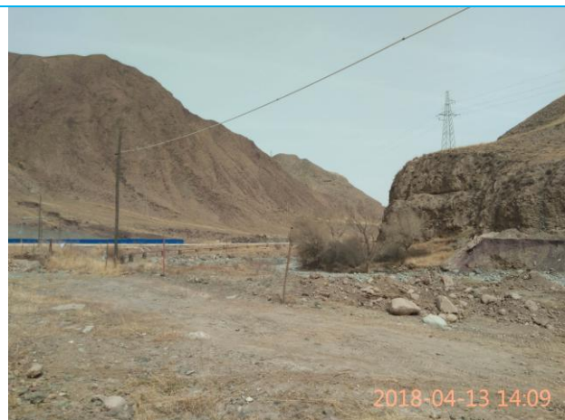
施工营地恢复情况
