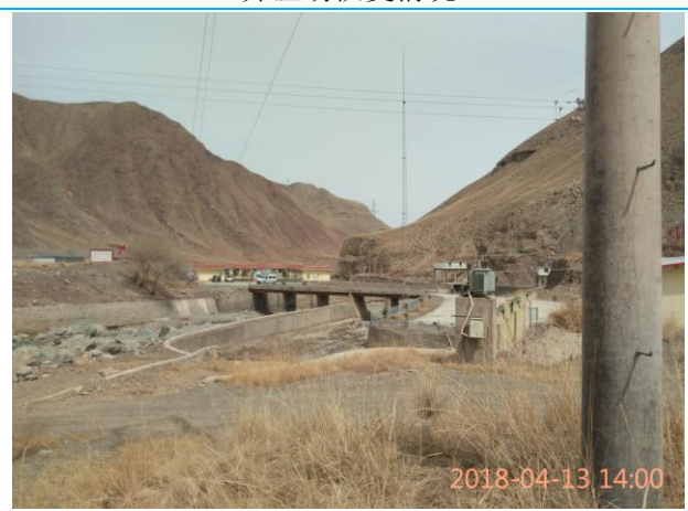
厂区周边绿化情况
